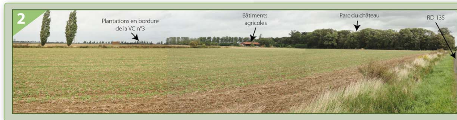
Vue depuis l'angle Sud-Ouest
