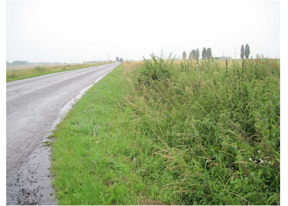
Berme de route
